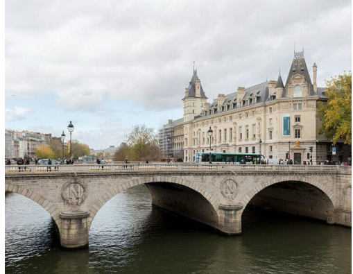
Le Pont au Change le 1er novembre 2022 : le pont de 1858–1860, dégagé, avec le Palais de justice et la Conciergerie.
