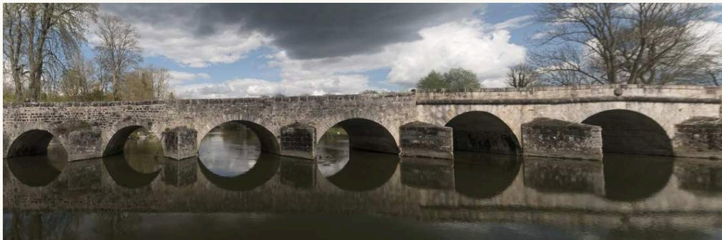
56 VUE DE CONTEXTE L'ancien pont sur le Loing, à Grez, vu de l'aval.
